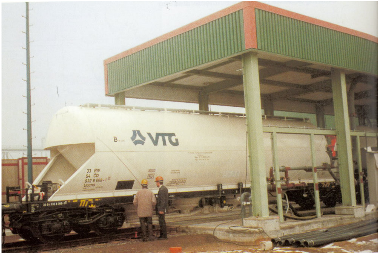
Abbildung 19: Inbetriebnahme der Kalksteinmehl-Bahmentladung, Braunkohlekraftwerk Schkopau
