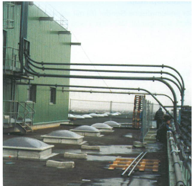
Abbildung 9 (oben links): Siloentladung nach Puls-Pneu Förderverfahren (Quelle SST)
